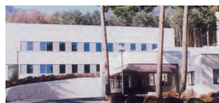
中央研究所新棟
