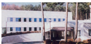
中央研究所新棟
