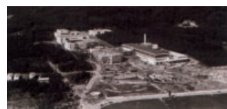
駒ヶ根工場建設中の風景
